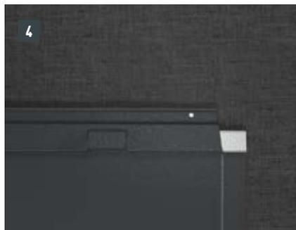
Au niveau où doit être réalisé le pliage vers le haut, encochez l'agrafe brevetée supérieure de manière à laisser une agrafe d'accrochage et pliez la R.16 ou le panneau de toiture FX.12 à 30 mm vers le haut, à angle droit par rapport à la surface du toit (Fig. 3 + 4).
