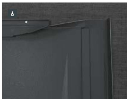
Au niveau de l'abergement haut du raccordement, l'agrafe d'accroche supérieure de la R.16 ou du panneau de toiture FX.12 à poser est découpée et encochée à environ 200 mm. L'agrafe d'accroche est repliée vers l'arrière et le dépassement latéral est replié à 90° (Fig. 5 + 6). L'abergement haut du raccordement est mis en place.
