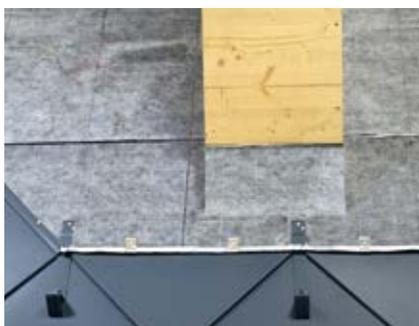
Figure 108 • Abergement de fenêtre de toit – Particularité pour les losanges de toiture 29 x 29 et 44 x 44
