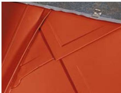
Figure 111 • Tabatière – Particularité pour les losanges de toiture 29 x 29 et 44 x 44
