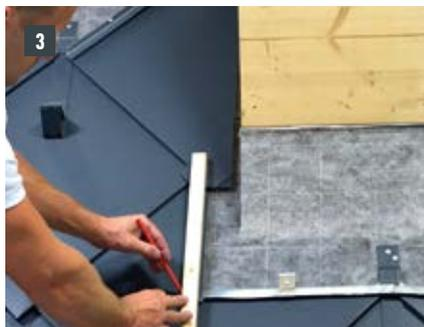
Figure 106 • Raccordement de cheminée – Losanges de toiture 29 x 29 et 44 x 44 – Abergement latéral
