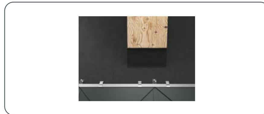
Figure 105 • Raccordement de cheminée – Losanges de toiture 29 x 29 et 44 x 44 – Abergement bas
