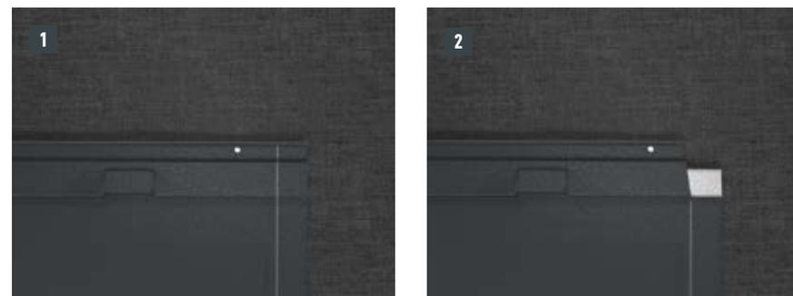
Au niveau où doit être réalisé le pliage vers le haut, encochez l'agrafe brevetée supérieure de manière à laisser une agrafe d'accrochage et pliez la R.16 ou le panneau de toiture FX.12 à 30 mm vers le haut, à angle droit par rapport à la surface du toit.
