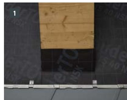
Faites remonter les bardeaux et bardeaux DS.19 jusqu'à pouvoir poser la dernière rangée de la couverture de toit PREFA sous la cheminée en continu.
