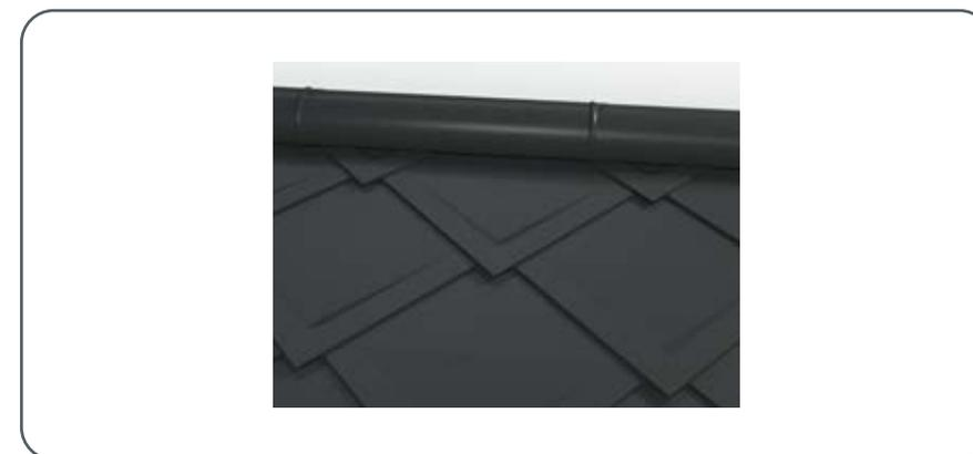
Figure 69 • Pose sans demi-losanges de fin
