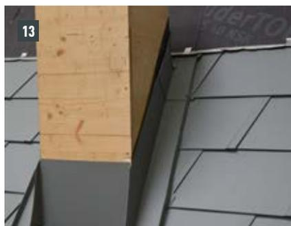
Rabattez les agrafes verticales des abergements latéraux dans la partie supérieure et découpez l'abergement haut ainsi que les abergements latéraux avec un supplément de 30 mm. Réalisez le rabat – il est maintenant possible de poursuivre la couverture de la surface du toit sur le raccordement de cheminée.
