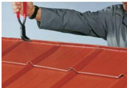
Figure 71 • Réalisation d'un faîtage simple avec agrafe d'accroche
