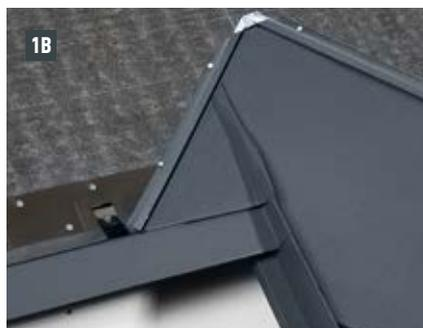
Dans la plupart des cas, pour réaliser les décrochements de toit avec des losanges de toiture 29 x 29 ou 44 x 44, l'artisan doit façonner un larmier. Cela permet de commencer la pose facilement avec une tuile de départ de losange de toiture 29 x 29 ou 44 x 44 (Fig. 1A + 1B).
