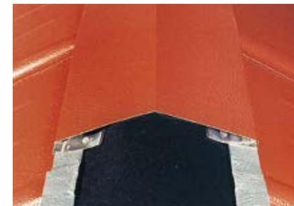
Figure 73 • Réalisation d'un faîtage avec faîtière simple
