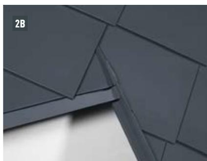
La rangée suivante de losanges de toiture peut ensuite être posée sur toute la largeur (Fig. 2A + 2B).
