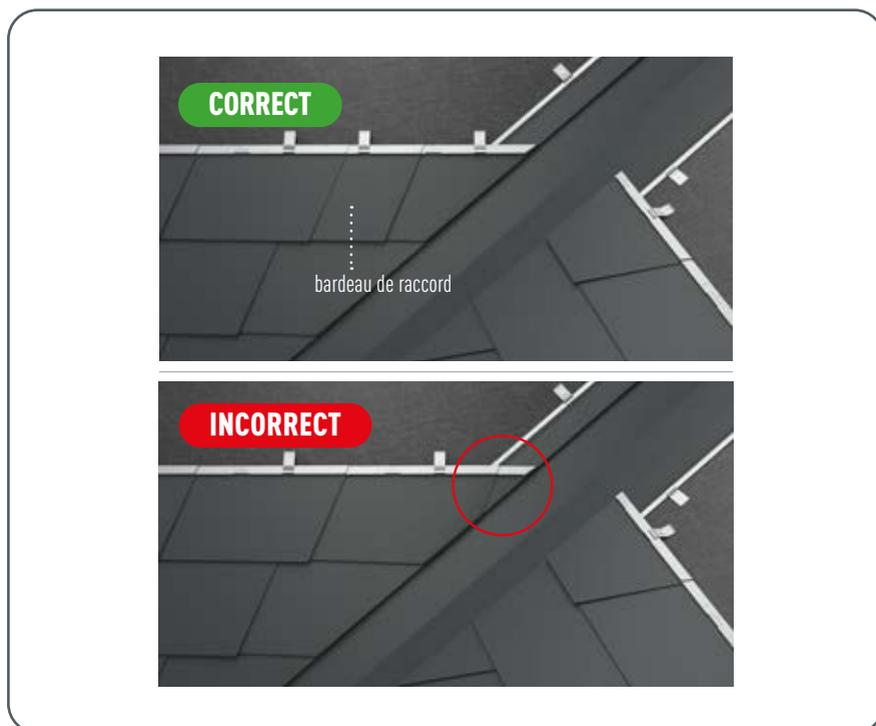
Figure 62 • Réalisation de la noue – Particularité pour les bardeaux
