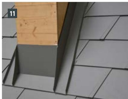
Préparez le raccordement (abergement haut et abergements latéraux) et fixez-le aux abergements latéraux sur la sous-construction à l'aide de pattes de maintien.
