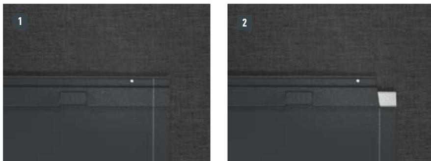
Au niveau où doit être réalisé le pliage vers le haut, encochez l'agrafe brevetée supérieure de manière à laisser une agrafe d'accrochage et pliez la R.16 ou le panneau de toiture FX.12 à 30 mm vers le haut, à angle droit par rapport à la surface du toit (Fig. 1 + 2).
