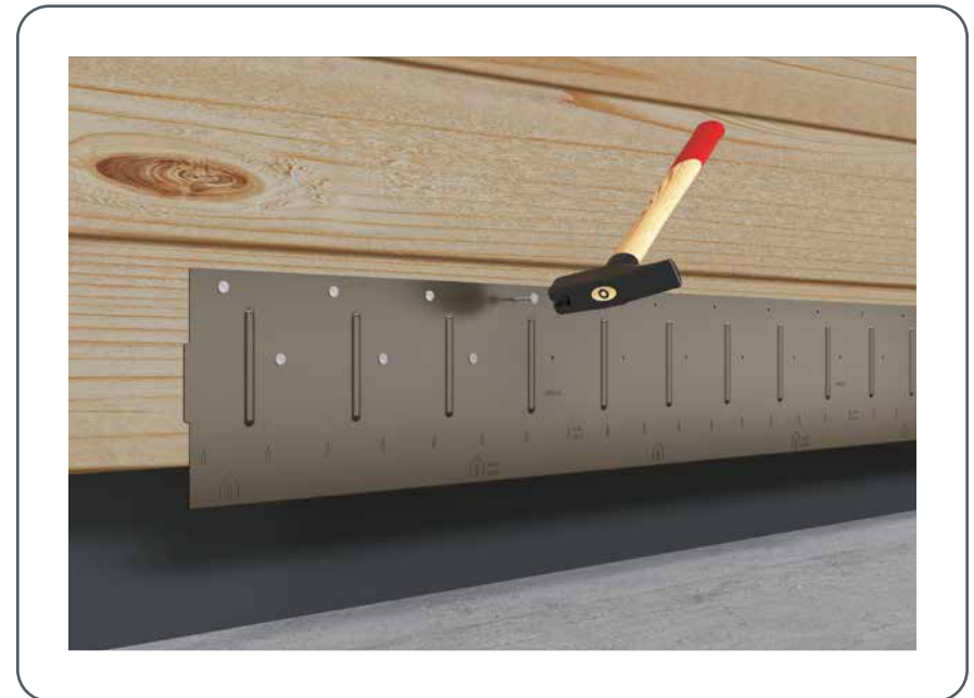
Abbildung 59 • Saumstreifen – Befestigung
