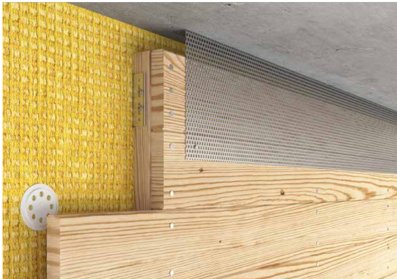
Abbildung 70 • Oberer Anschluss – Vorbereitung
